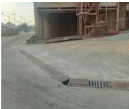
รูปที่ 27 รางระบายรวบรวมน้ำฝนที่ปนเปื้อน
