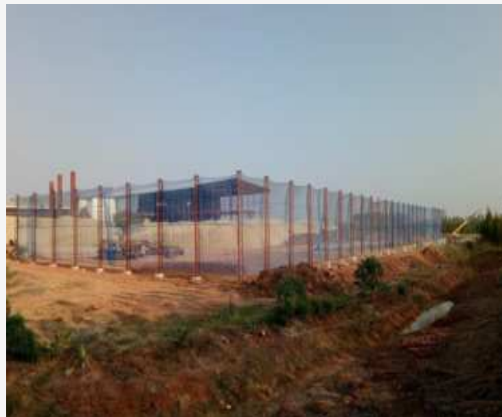
จัดทำโครงเหล็กตาข่ายพลาสติกโพลีเอทิลีนรอบพื้นที่กองขานอ้อยเพื่อลดการฟุ้งกระจาย
